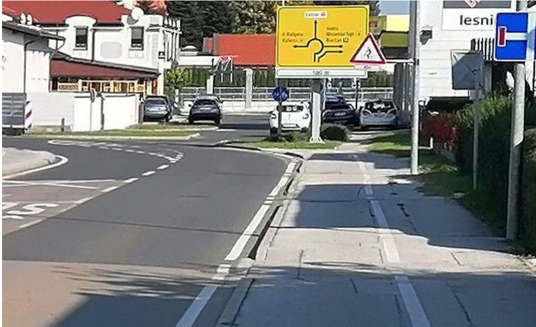
Slika 30. Pri križišču z Lesnino zmanjka prostora za kolesarsko stezo in je speljana na vozišče v dolžini 50 m
